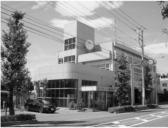
朝霞地区一部事務組合事務局 埼玉県南西部消防本部・朝霞消防署
